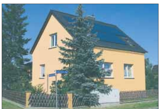
Dieses Haus in Cottbus war eine wahre Energieschleuder. Durch eine umfassende energetische Sanierung und die Kombination von Solarflächen und Brennwerttechnik konnte der Heizölbedarf von 5.000 auf 1.500 Liter im Jahr gesenkt werden. swb-Bild: IWO
