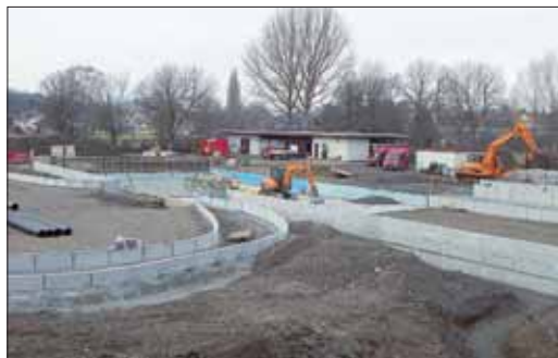
Die Arbeiten am Worblingener Naturbad gehen zügig voran. swb-Bild: frö
