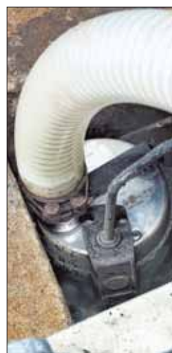
Diese Pumpe benötigt keinen Schwimmer mehr. Dadurch kann das Gerät in einem sehr kleinen Gehäuse untergebracht werden. swb-Bild: Grundfos
