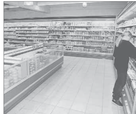
Nach 13 Jahren erfolgreicher Entwicklung wurden viele Geräte erneuert. Der Bereich der Milchprodukte spart nun durch neue Gerätetechnik sogar beträchtliche Mengen an Energie.
