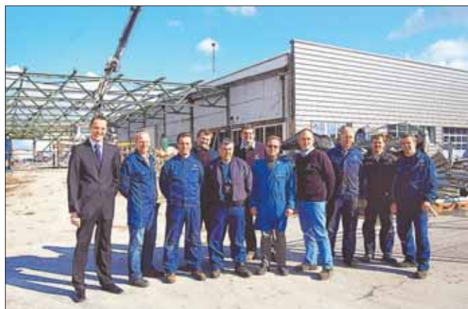
Schon nach wenigen Tagen stehen nur noch Umriss der bisherigen Nutzfahrzeuge-Werkstatt von Bölle Südstern. In sieben Monaten könnten die Mitarbeiter in den neuen hochmodernen Werkstatttrakt einziehen. Mit im Bild der Leiter von Südstern Bölle in Singen, Rainer Leenen (links) und daneben Werkstattleiter Peter Otten. swb-Bild: of
