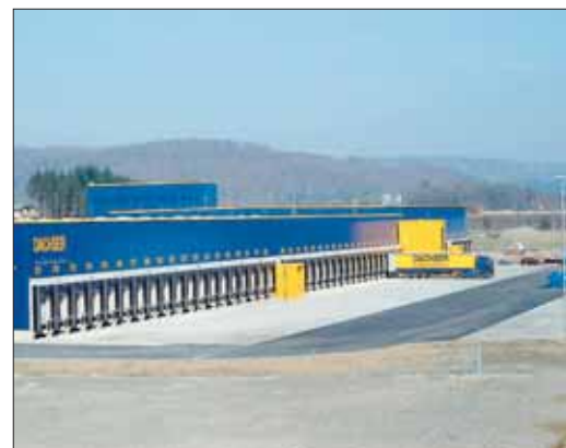
Nach genau einem Jahr Bauzeit konnte nun der Umzug von Dachser nach Steißlingen vollzogen werden. 21 Millionen Euro investierte das Unternehmen in den neuen Standort im Industriegebiet Hardt.
