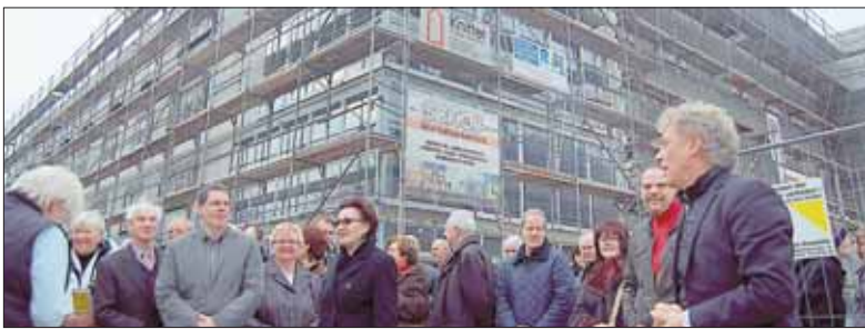
Bald ist es fertig gestellt, das neue Servicehaus Sonnenhalde an der Ecke Schaffhauser-Mühlenstraße.
