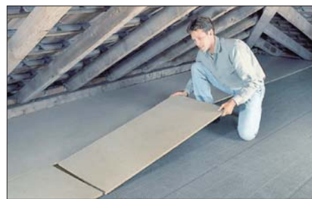
Die Dämmung der obersten Geschossdecke kann vom Hausbesitzer oft in Eigenleistung ausgeführt werden swb-Bild: www.energie-fachberater.de
