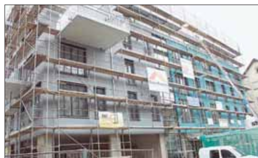
Eine »luftige« Bauweise zeichnet die Bebauung aus.
