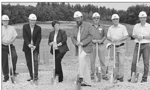
Nun geht es an die Hochbauten des geplanten Ferienparks in Orsingen: Den ersten Spatenstich nahmen vor: Peter Hesse von der Sparkasse Bodensee, Eigeltingens Bürgermeister Alois Frittschi, Beate Klatt, die Ortsvorsteherin von Wahlwies, Bernhard Volk, der Bürgermeister von Orsingen-Nenzingen, Günter Ziegler vom Landesverband der Campingplatzunternehmer, Architekt Nicola Risoli und Investor Jörg Krane. Auf dem Foto fehlt der zweite Investor Peter Blum.
