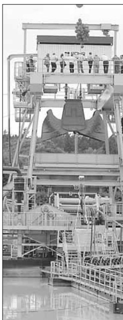
Die Gäste der Einweihungsfeier durften anschließend den Schwimmbagger besichtigen, was sie mit Begeisterung taten. swb-Bild: gh
