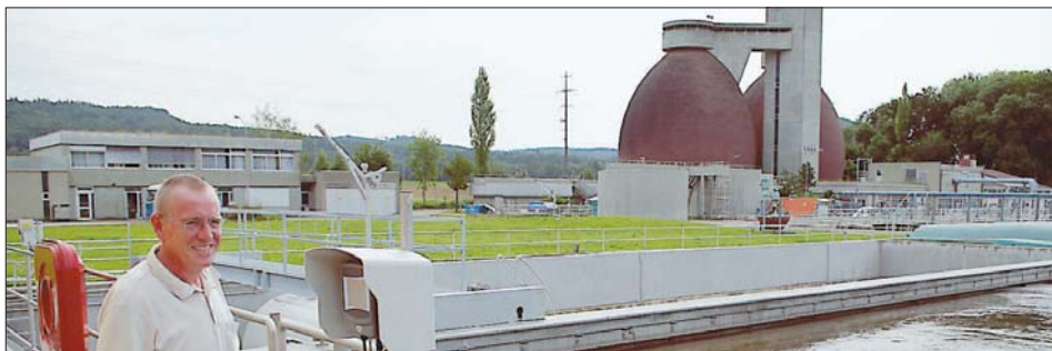
Eine neue Anlage zur Vorbehandlung von Abwässern aus der Klärschlamm-trocknung wurde nun in der Kläranlage Ramsen in Betrieb genommen. Die Kläranlage wird dadurch erheblich leistungsfähiger. Im Bild der Leiter der Kläranlage, Klaus Bölling.
