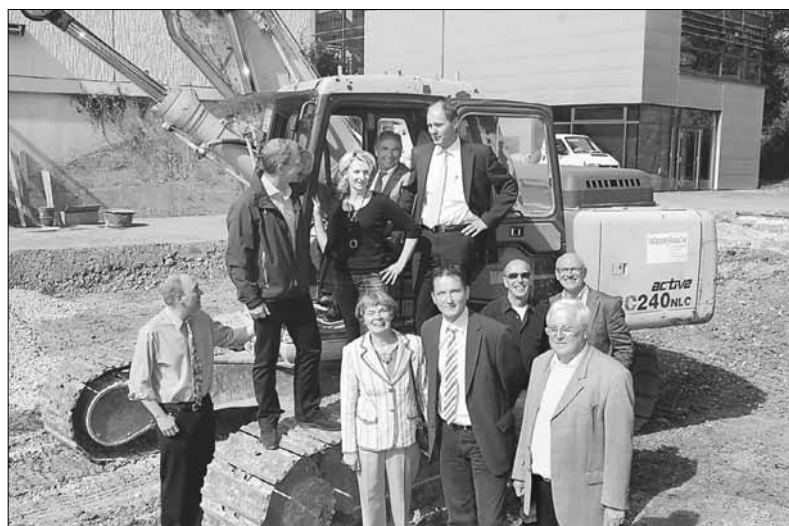
Die Bauarbeiten für den Anbau am Friedrich-Wöhler-Gymnasium haben begonnen. Direktor Horst Scheu erprobte sich beim Spatenstich als Baggerführer. Der Neubau wird ein naturwissenschaftliches Kompetenzzentrum beherbergen. Auch Bürgermeister Bernd Häusler war gekommen, sowie eine Abordnung von Gemeinderäten und die beiden Architekten Wolfgang Riede und Birgit Winkler. Auch eine Bibliothek wird eingerichtet werden, die auch anderen Schulen zur Verfügung stehen soll. swb-Bild: frö
