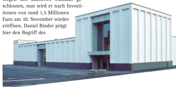
Ein Architektmarkt ist der Rewe-Markt an der Holzcekstraße in Singen in mehrwöchigen Umbauten geworden. Am 10. November ist Eröffnung. swb-Bild: Binder
