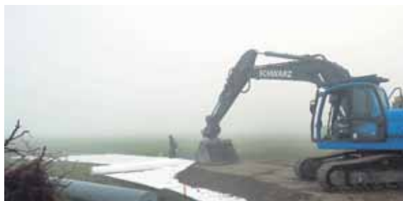
Der Wegebau für die Sanierung der Bohlinger Schlammteiche hat begonnen. Die Fahrstraße wird durch Planen gegenüber dem Untergrund abgesperrt.
