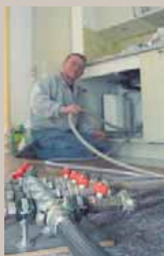
In mehreren Schritten werden Rohre über ein angeschlossenes System von Ablagerungen befreit und mit einer Schutzschicht für die Zukunft versehen. swb-Bild: D+D
