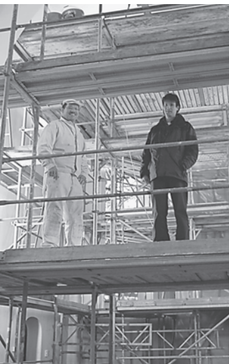
Pfarrer Michael Fischer (rechts) neben dem Stuckateur Klaus Hinze aus Engen auf dem Gerüst in der Aacher Stadtkirche.
