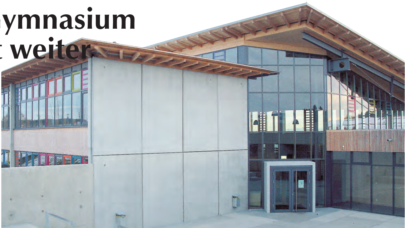
Im Sommer soll mit dem 2. Bauabschnitt des Engener Gymnasiums begonnen werden.
