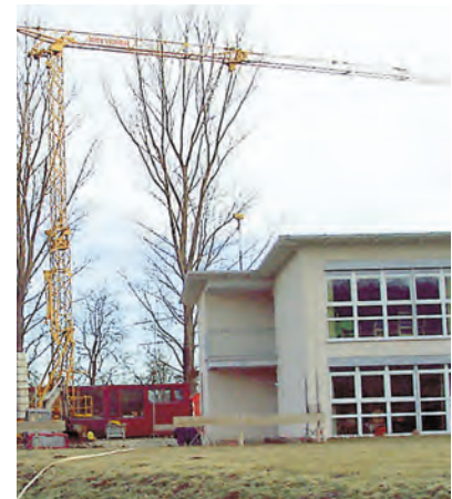
Mit dem ersten Bauabschnitt des Anbaus wurde am Haus am Mühlebach begonnen.
