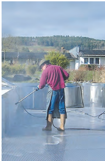
Bademeister Roland Kapitel beim Entkalken des Nichtschwimmerbeckens mit dem Dampfstrahler.
