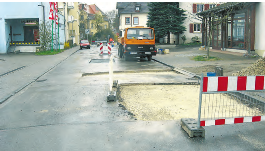
In Gottmadingen jetzt die Winterschäden ausgebessert. swb-Bild: Gemeinde
