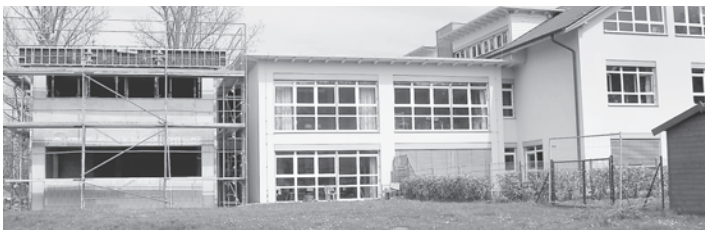
Der Schulanbau der Heimsonderschule »Haus am Mühlebach« schreitet zügig voran.
