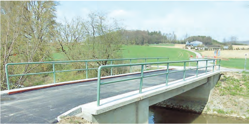
Die Sanierung der Biberbrücke zwischen Bietingen und Randegg konnte abgeschlossen werden.
