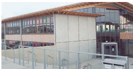
Das Engener Gymnasium geht mit dem Baubeginn des 2. Bauabschnitts seiner Fertigstellung entgegen.
