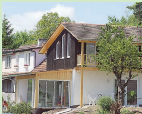
Aus einer Scheune in Büsingen wurde ein heimeliges Radlerhotel, das auch für alle anderen Gäste gerne Unterkunft bietet. Nach nur 70 Tagen Bauzeit konnte es nun eingeweiht werden. swb-Bild: of
