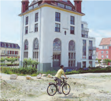
Nur bis Jahresende wird die Rad-Teststrecke am Gottmadinger Sudturm als Provisorium geduldet. swb-Bild: of
