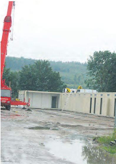
Die Container für die Christliche Schule im Hegau wurden hinter dem Sportheim in Hilzingen aufgestellt.
