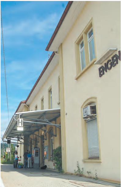
Teure Angelegenheit: Der Bahnhof in Engen soll modernisiert werden. swb-Bild: mu
