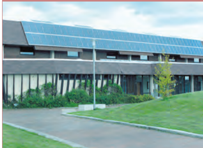
Das neue Sonnenkraftwerk an der Stadthalle Engen
