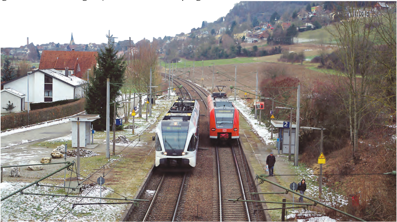
Recht gut ist Bietingen über den Haltepunkt der Bahn angeschlossen, aber der Zustand der Zugänge und Bahnsteige ist vor-sintflutlich. Das soll sich nun baldigst ändern.
