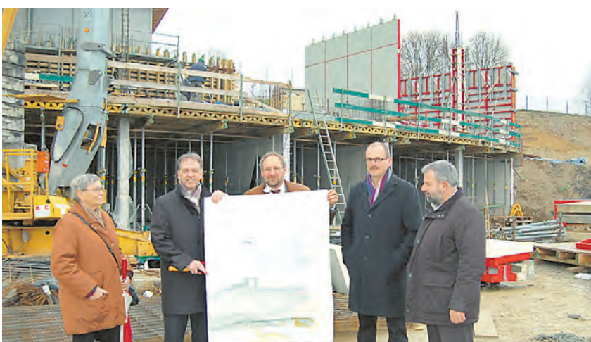
Finale bei der größten Hochbaumaßnahme der Stadt Engen: Der 2. Bauabschnitt des Gymnasiums wurde im Juni begonnen. Bis zum Schuljahresbeginn 2011/2012 sollen weitere sechs Klassenzimmer, drei Lehrerarbeits- und Fachräume fertig gestellt sein, damit die Oberstufe ausreichend Raum findet. Investiert werden in den Neubau rund 2,4 Millionen Euro. Nur die Höhe des Landeszuschusses ist noch nicht geklärt.
