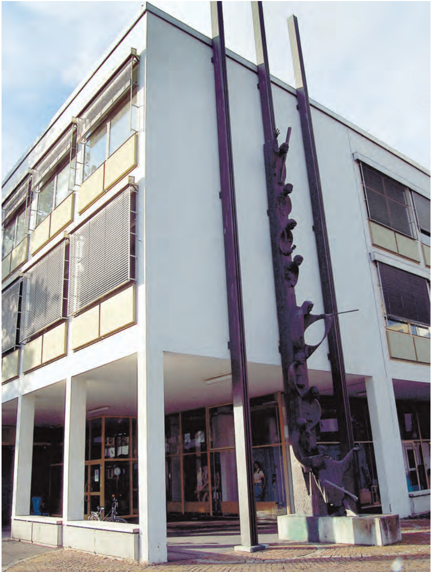
Das alte Berufsschulzentrum in Radolfzell muss weichen: Die Pläne für einen Neubau wurden im Planungsausschuss vorgestellt. Das Gebäude wird in drei Bauabschnitten parallel zum laufenden Schulbetrieb erstellt. swb-Bild: Weiß
