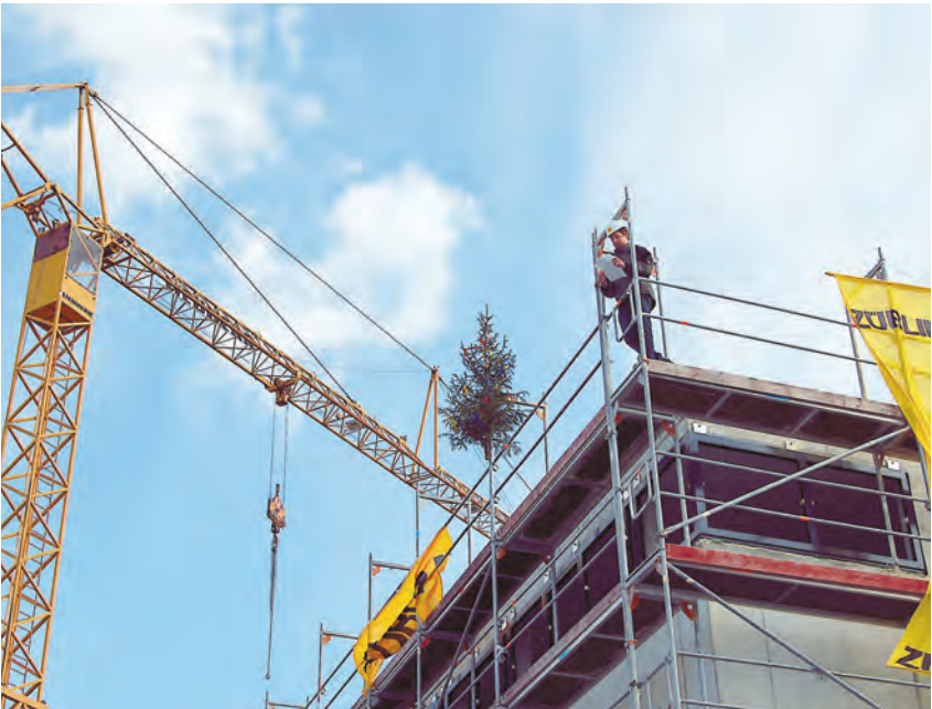
»Nach harten, arbeitsreichen Tagen hat nun die Feierstund' geschlagen«: Richtfest beim neuen Polizeirevier in Radolfzell.
