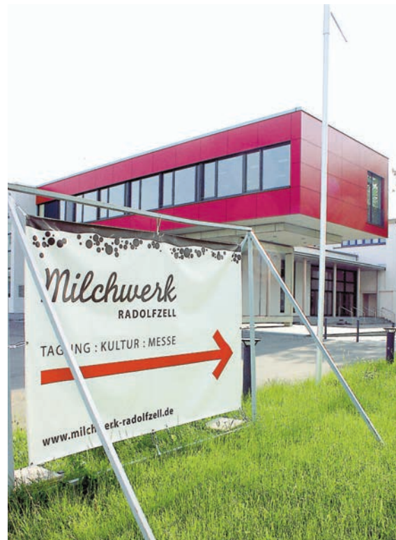
Um die Kostenexplosion beim Umbau und der Erweiterung des Milchwerks ging es in der gestrigen Sondersitzung des Radolfzeller Gemeinderats. Die Grundlage bildete der Prüfbericht der Gemeindeprüfungsanstalt Baden-Württemberg
