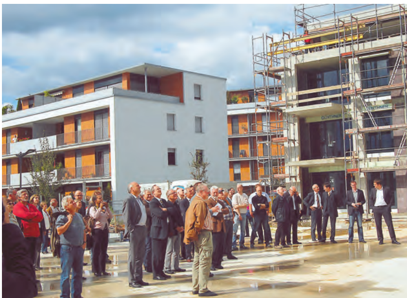
Da lacht selbst die Sonne plötzlich beim Richtfest des zweiten Bauabschnitts des SeeParks in Radolfzell. Auch wenn es hier am Bau keine Zimmerleute mehr gibt, schauen alle auf die Richttanne hoch droben. swb-Bild: li
