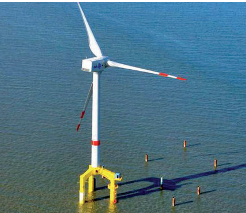
Der gesamte Windpark „BARD Offshore I“ umfasst insgesamt 80 dieser Windkraftanlagen.
