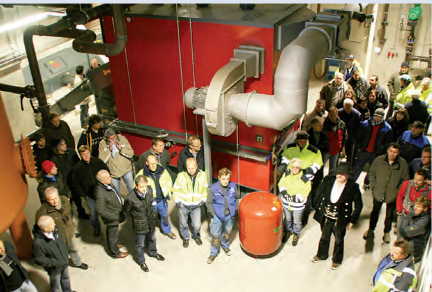
Am 03. Dezember wurde in der Heizzentrale Möggingen Richtfest gefeiert.
