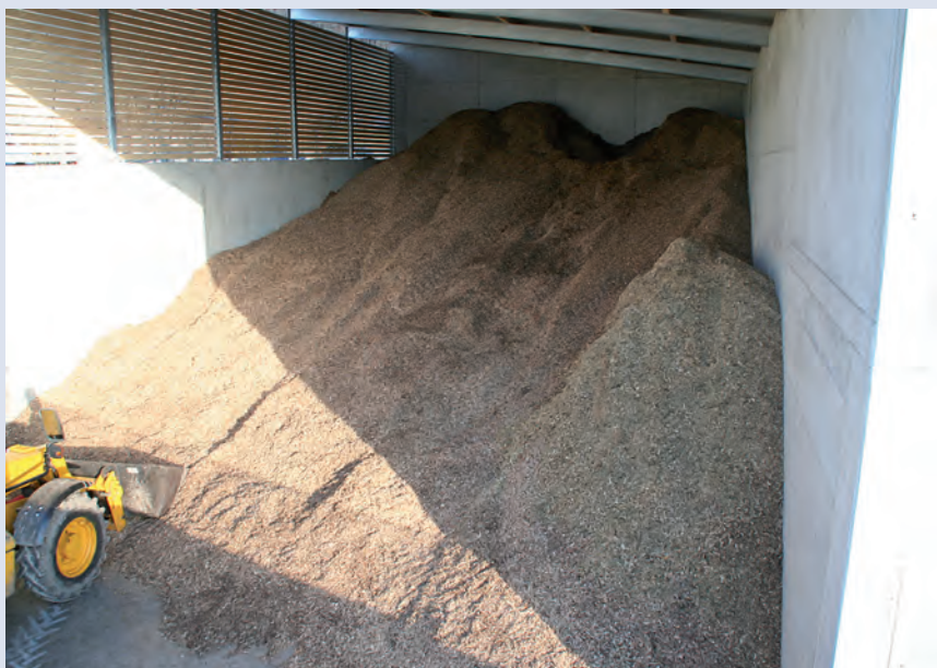
Das Holzhackschnittzellager an der Heizzentrale wurde aufgefüllt.
