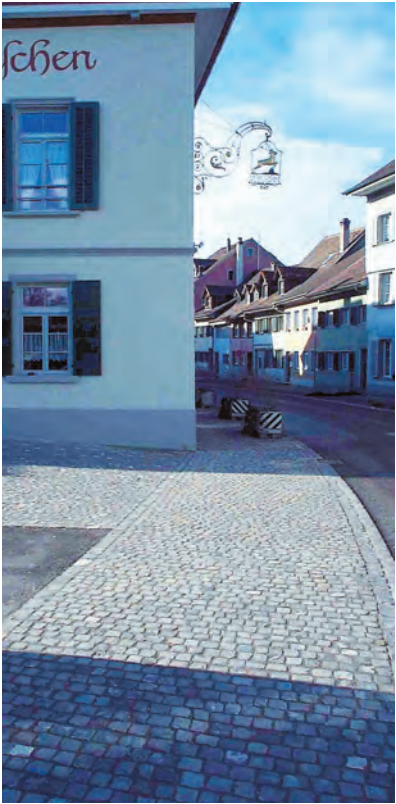
Nach einer langen Winterpause wird seit einigen Tagen das Pflaster an den Trottoirs am Obertor eingebaut.
