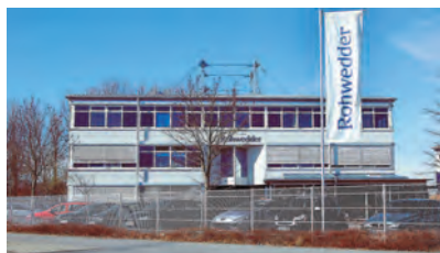
Bei Rohwedder läuft das Insolvenzverfahren.
