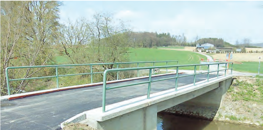
Die Sanierung der Biberbrücke zwischen Bietingen und Randegg konnte abgeschlossen werden. swb-Bild: Gemeinde Gottmadingen
