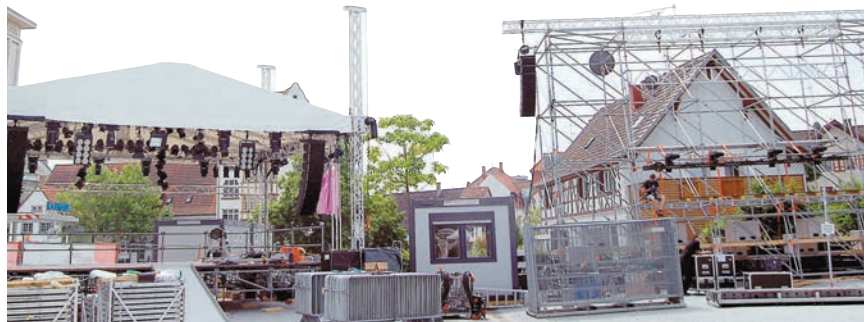
Die Sparkassen-Arena auf dem Singener Rathausplatz ist im Entstehen. Am Freitag, 14 Uhr, wird das Public-Viewing zur Fußball-WM in Südafrika eröffnet. Das gibt das größte Fest der Stadt - vier Wochen lang! swb-Bild: frö
