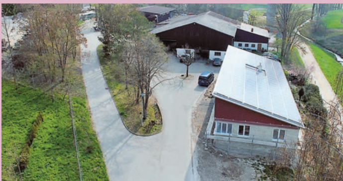
Das neue Büro- und Sozialgebäude am Bauhof in Hilzingen wird am kommenden Wochenende offiziell eingeweiht. Damit wird der Standort an der L 190 westlich des Hilzinger Gewerbegebiets erheblich aufgewertet.
