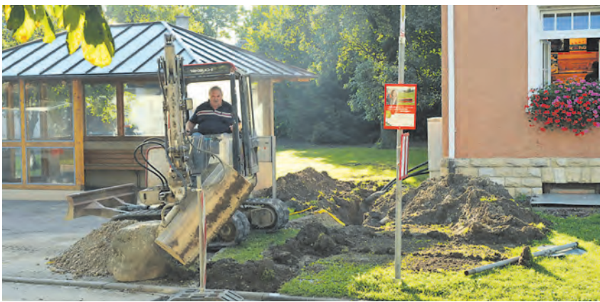
Mit Spülbohrungen werden die Kabel für eine gute DSL-Verbindung in Watterdingen verlegt.
