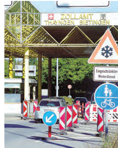
Die Gemeinschaftszollanlage Bietingen/Thayngen gibt es seit 20 Jahren. Sie ist nach Basel zweitgrößtes Tor zwischen Deutschland und der Schweiz. swb-Bild: of
