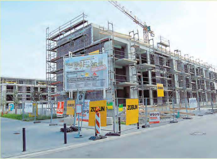
Der Radolfzeller SeePark der GVV zeigt zum Richtfest seine Kubatur in voller Größe. 60 Wohnungen entstehen hier, 32 sind schon verkauft. swb-Bilder: li
