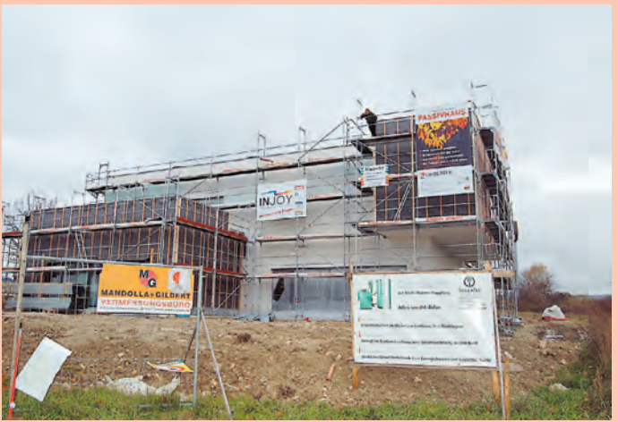
Es geht zügig voran am Ortseingang in Engen, wo das neue INJOY- Gesundheitszentrum entsteht.
