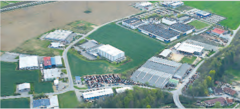
Von 1990 bis 1992 wurde das Industriegebiet erschlossen. swb-Bild: Flug und Bild Plessing
