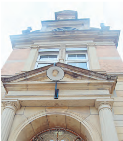
Teile der Grund-, Haupt- und Werkrealschule Stockach werden saniert.
