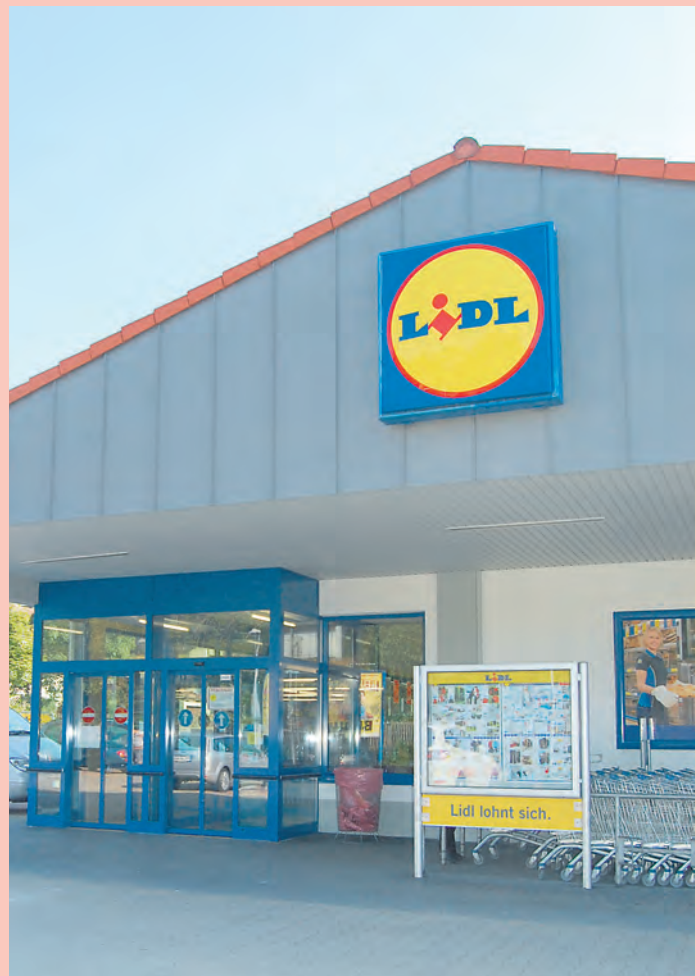
Die LIDL-Filiale am Stadtwall 19 in Stockach wurde um eine Verkaufsfläche von 200 Quadratmetern erweitert.
