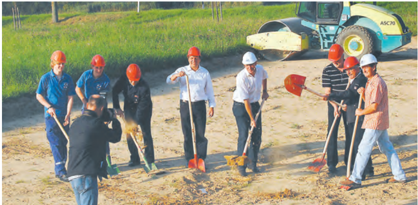
Der erste Spatenstich für das künftige Feuerwehrhaus in Moos. swb-Bild: li
