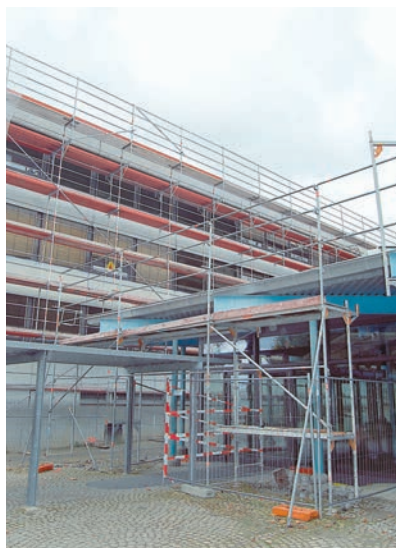
Die Stockacher Jahnhalle wird derzeit saniert.
