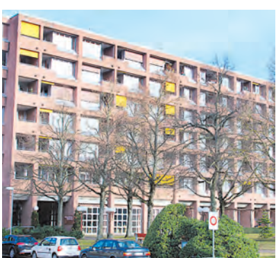
Das Altenwohnheim in Thayngen soll erweitert und umfangreich saniert werden. swb-Bild: of
