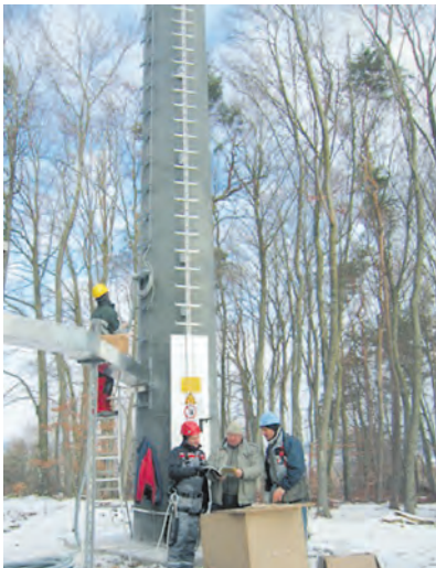
Techniker überprüfen in luftig-eisiger Höhe den neuen Funkmast bei Blumenfeld.
