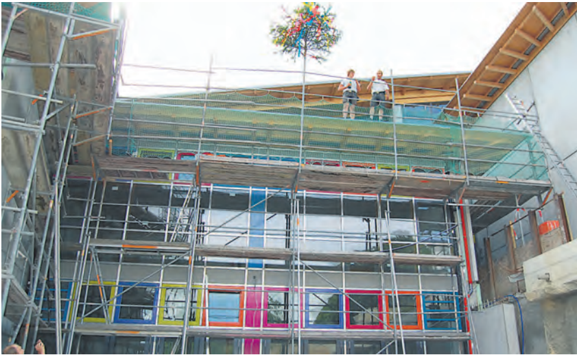
Mit dem Richtfest des 2. Bauabschnittes ist das Engener Gymnasium auf die Zielgerade gebogen.
