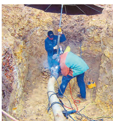
Die Gasleitung im »Hugenberg« ist repariert.
