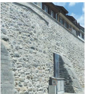
Die Sanierung der Engener Altstadtmauer ist abgeschlossen.
