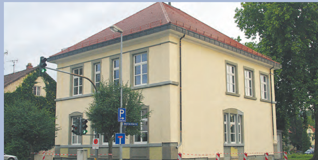
Das ortsbildprägende Gebäude der Bürgerschule von 1899 in Rielasingen wurde in einjähriger Bauzeit aufwändig saniert. Jetzt sind die Arbeiten fast vollständig abgeschlossen.
